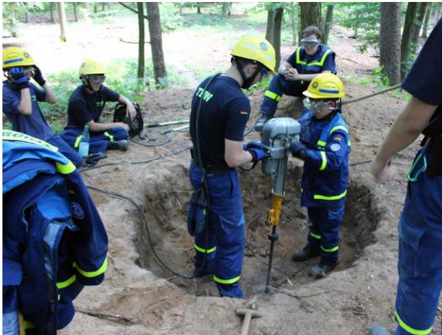
Aufgraben des Bunkerdaches und Durchbruch durch die Decke
