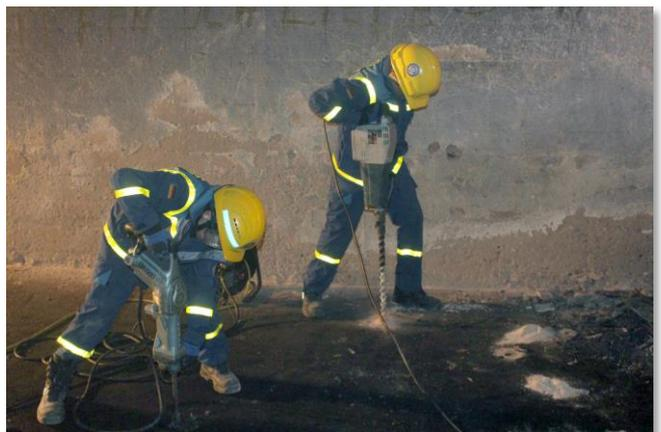
Bohren der Löcher in den Bunkerboden
